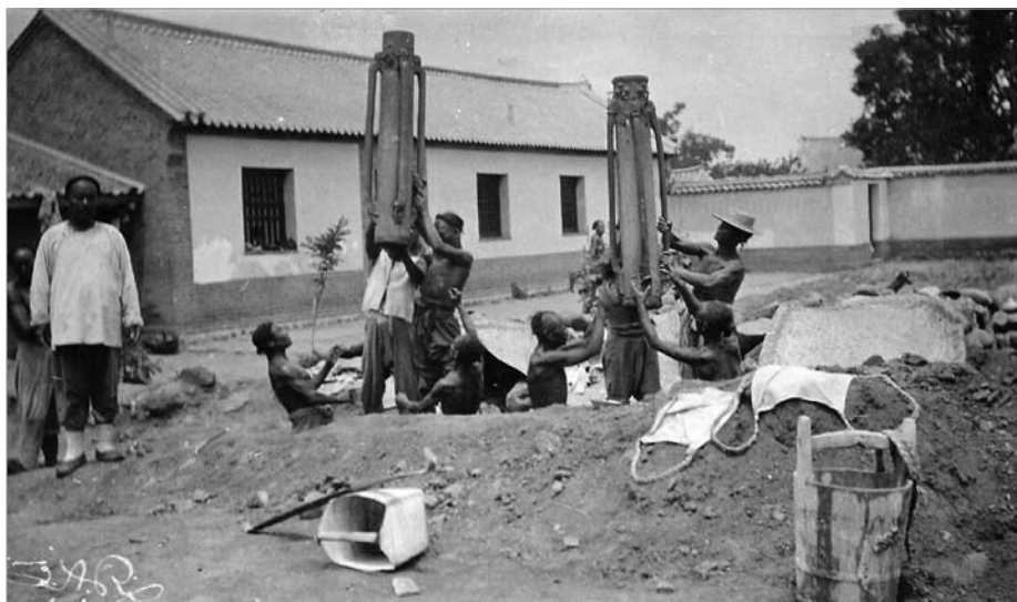
▲当时建筑之打夯奠基工程
